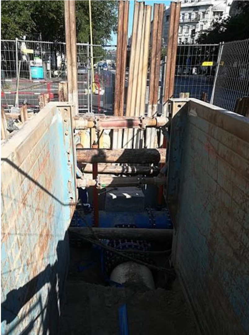
1. kép Ivóvízvezeték felújítás a Szent István körúton (Fotó: szerző)
